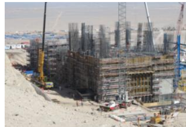
Obszar mokry – fundamenty składowiska rudy
