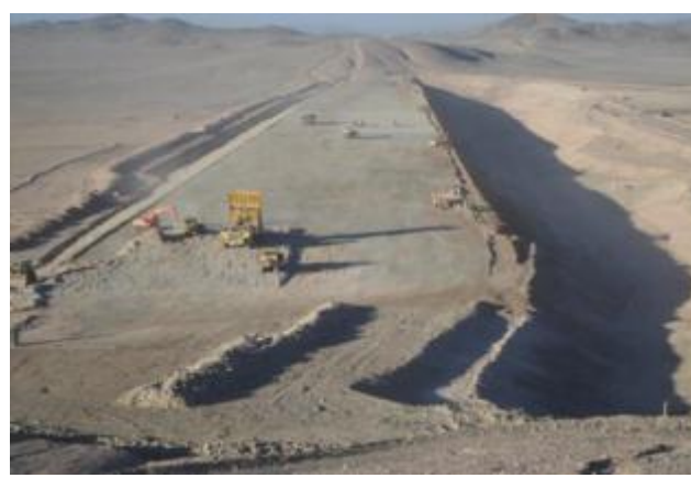
Budowa zbiornika odpadów poflotacyjnych
