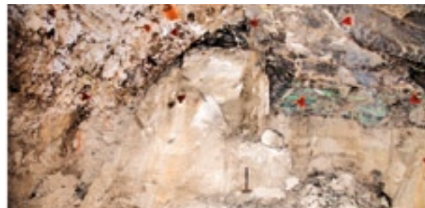
FOT. 1. USKOK O AMPLITUDZIE POWYŻEJ 4,0M. REJON SOLNEJ KOMORY MECHANICZNEJ. FOT. P. PANAJEW.
