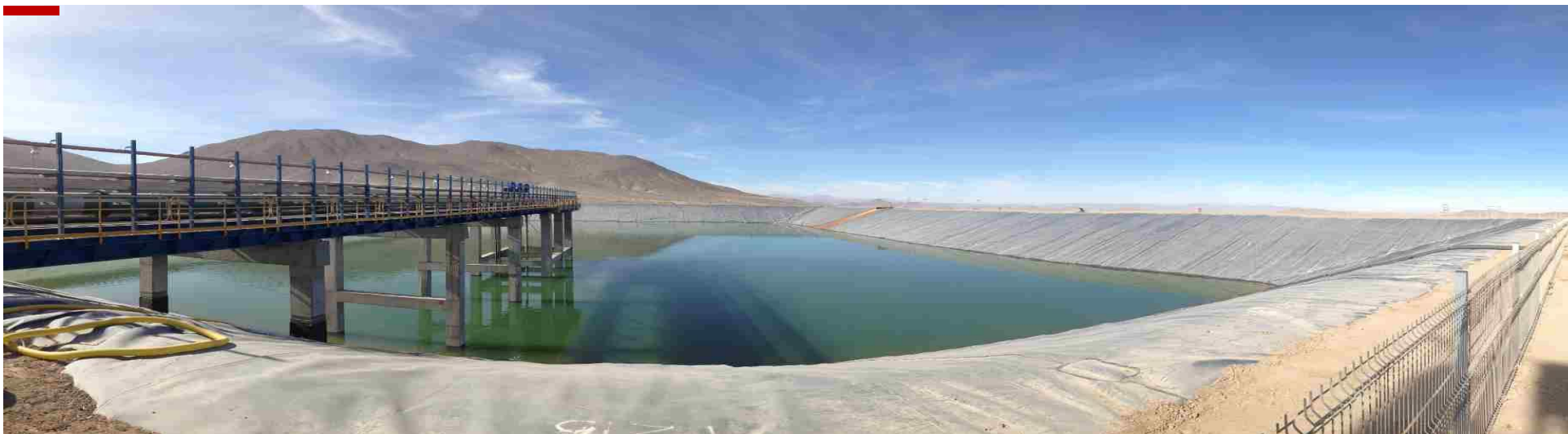
Zbiornik wody morskiej o pojemności 750 tys. m 3
