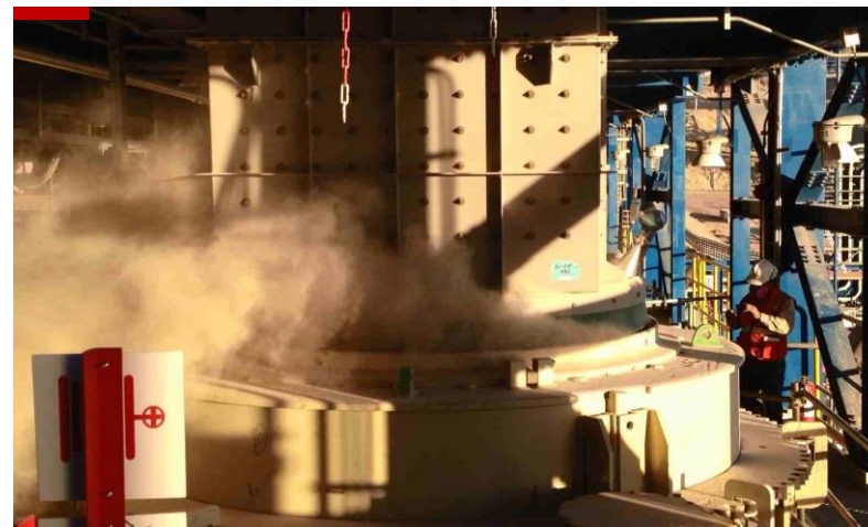
Krusząarka II stopnia w trakcie pracy
