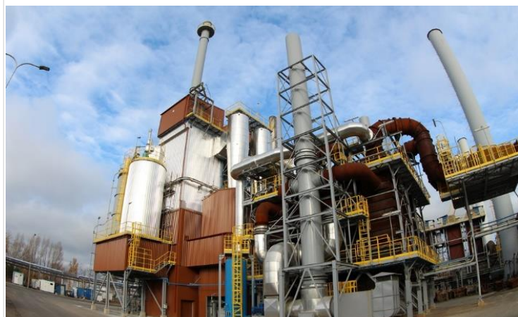
Odpylnia pieców anodowych HMG II
