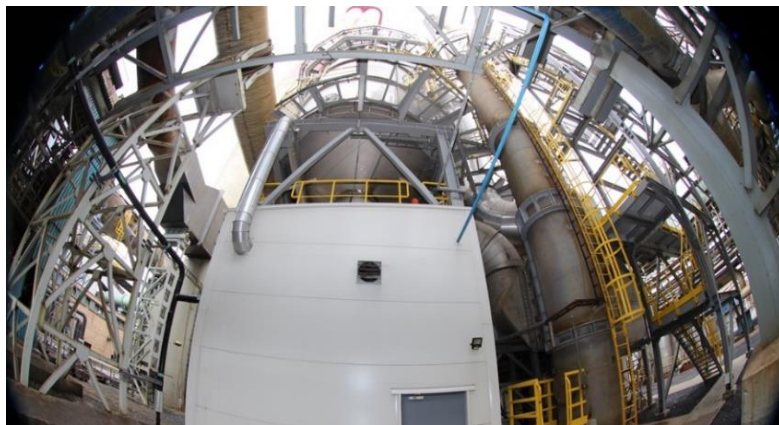
Technologia wykorzystująca elektrofiltr mokry w wydziale pieca zawiesinowego P-22
