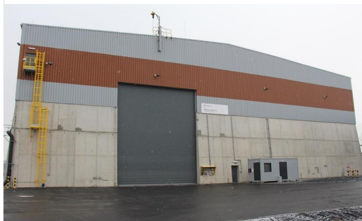
Magazyn na materiały ołowionośne w wydziale ołowiu P-31
