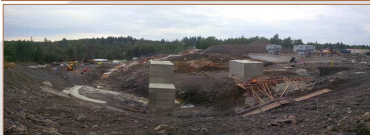
Fundamenty stacji transformatorowej 230 kV
