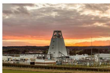
Plac budowy szybu GG-1
