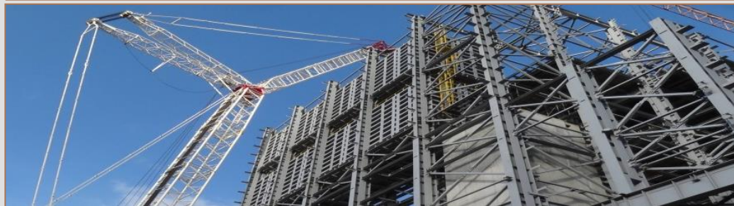
Konstrukcja Hali Pieców
