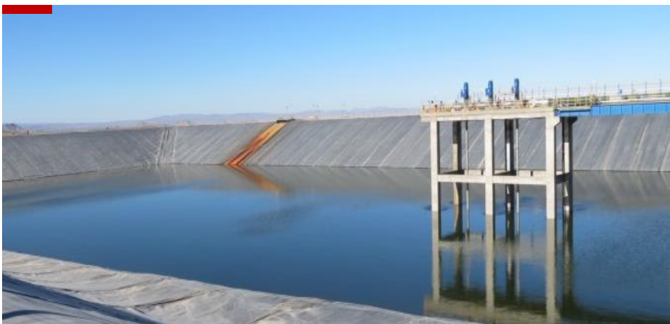
Zbiornik wody morskiej
