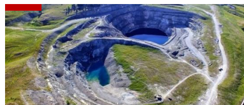
Budowa kopalni odkrywkowej Afton- Ajax w Kanadzie
