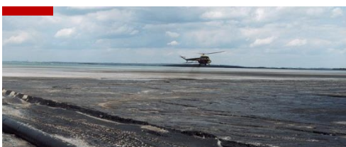
Rozbudowa obiektu unieszkodliwiania odpadów wydobywczych Żelazny Most
