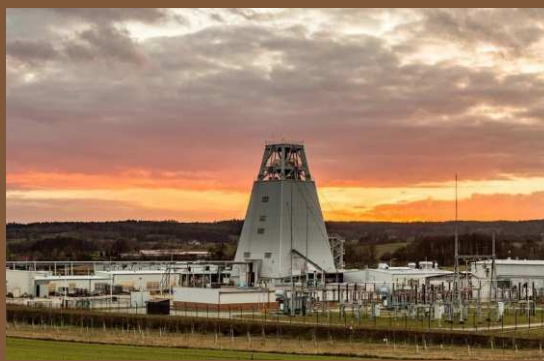
Plac budowy Szybu GG-1
