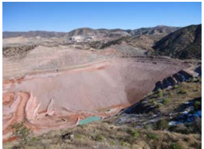
Contrafuerte del canal de desvío Pinto Creek en la mina Carlota, en Arizona (EE. UU.)
