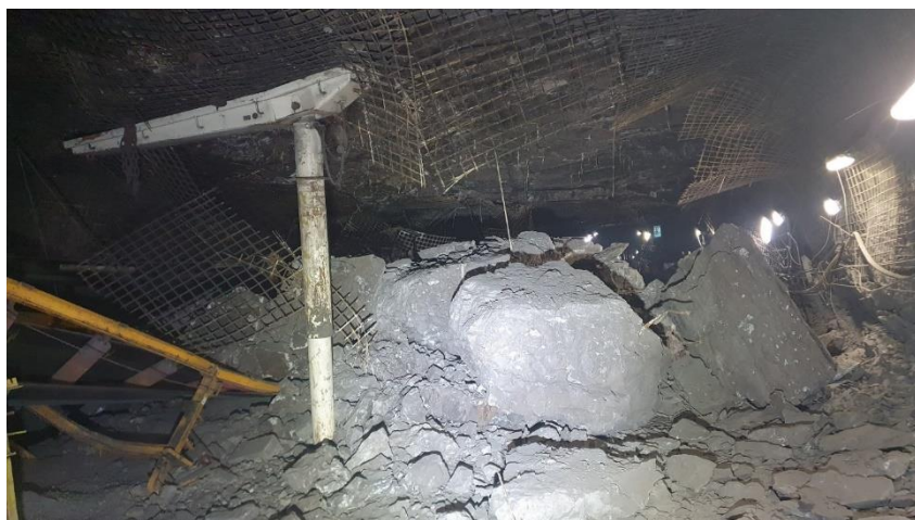
Przenośnik taśmowy L-196 po zawaleniu stropu.
